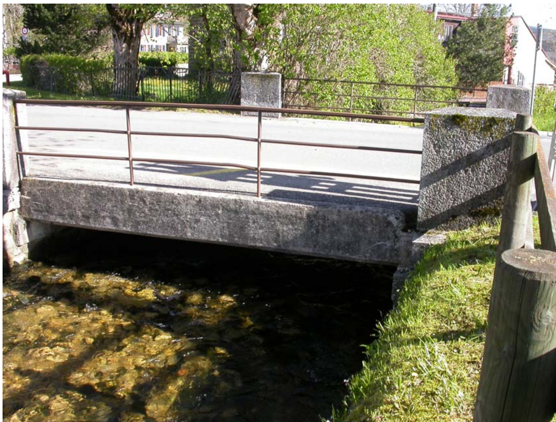
Le deuxième pont du bas de la rue des Forges n'offre par contre rien de bien particulier.
